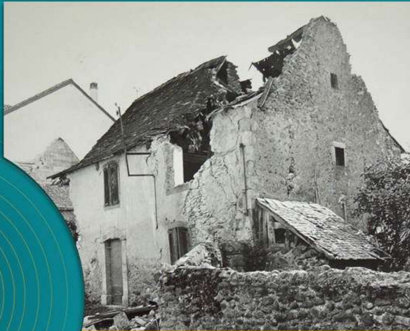
Construction endommagée sur Arette suite au séisme de 1967 (Collection Guy Jacquet)
