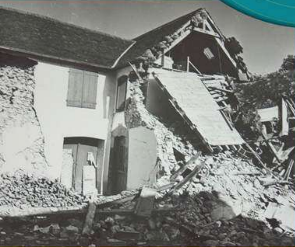
Construction endommagée sur Arette suite au séisme de 1967 (Collection Guy Jacquet)
