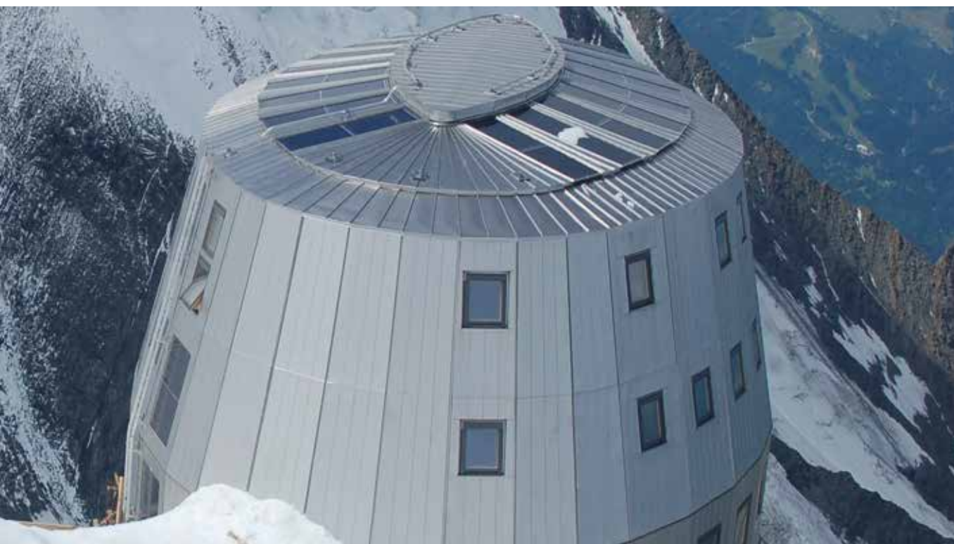
Refuge du Goûter © Jourjon : le toit du refuge est équipé de capteurs solaires thermiques (fonctionnement du fondoir à neige et de l'eau chaude sanitaire)
