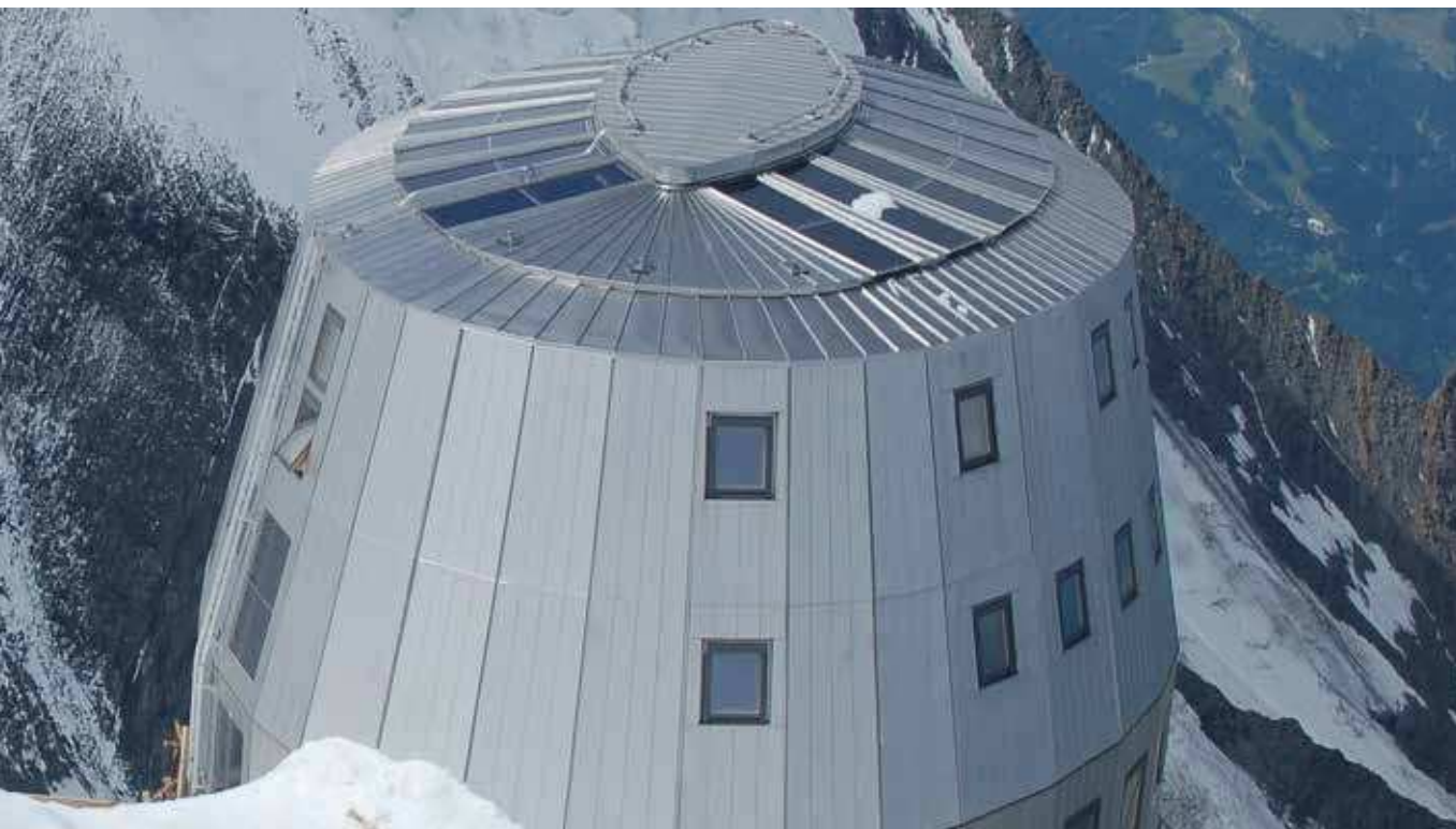
Refuge du Goûter © Jourjon : le toit du refuge est équipé de capteurs solaires thermiques (fonctionnement du fondoir à neige et de l'eau chaude sanitaire)
